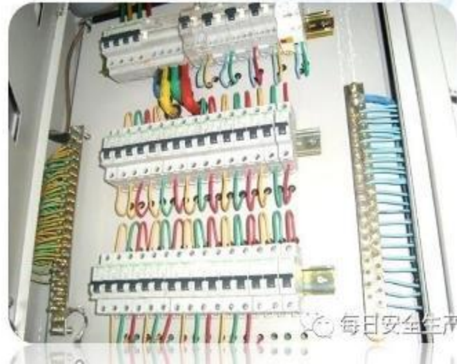
三相380V电路 导线颜色与用途
