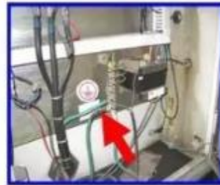
寿力20立方空压机的保 护接地端子和等电位排
