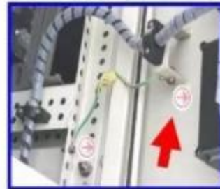
电柜与其门的保 护接地端子连接
