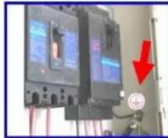
电箱的保护 接地端子
